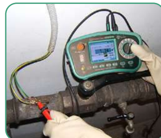
Sprawdzanie połączeń wyrównawczych
